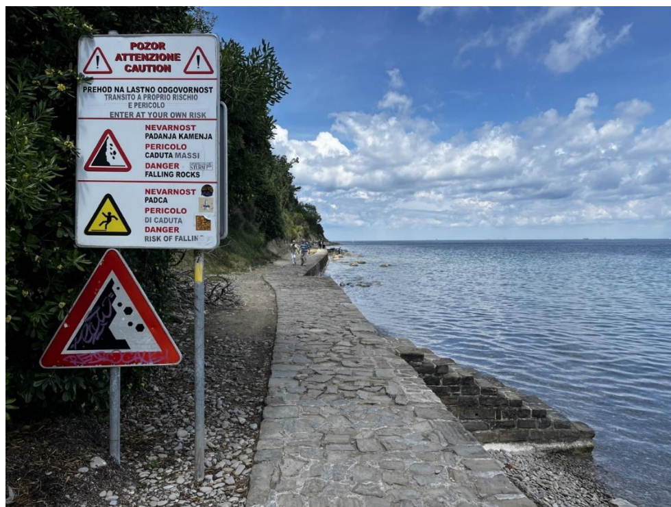
Slika 13: Tabla z opozorilom na nevarnost padajočega kamenja
